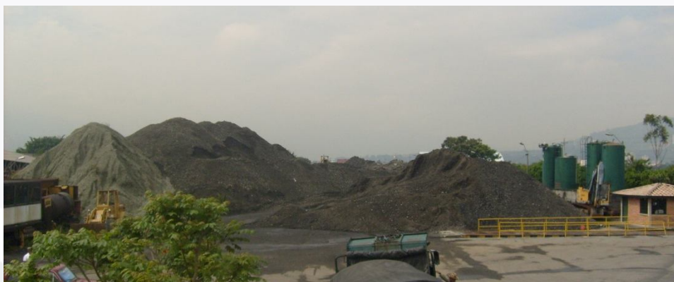
Planta de Reciclaje de la Secretaría de Infraestructura Física del Municipio de Medellín
